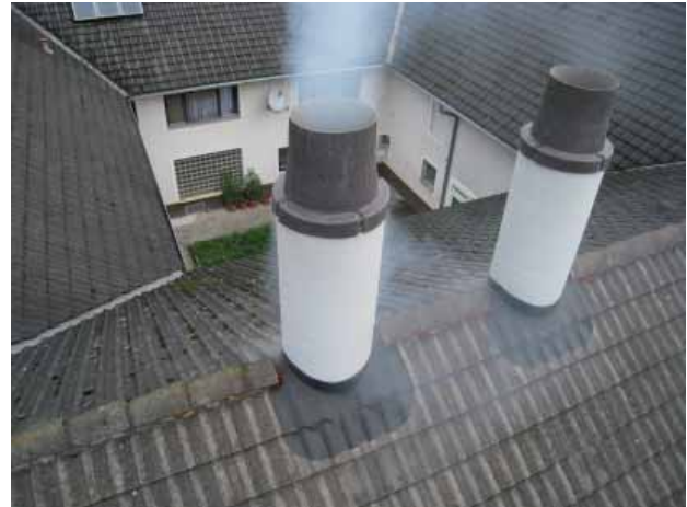
Abbildung 8: Funktionsumkehr an der Weitwurfdüse
