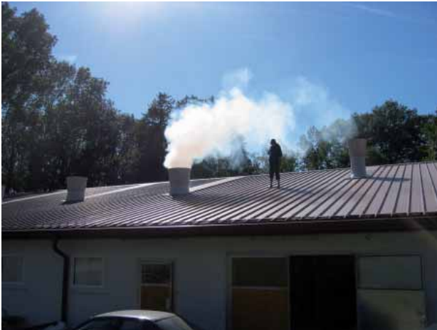
Abbildung 7: Bruch der Abluftfahne nach Diffusor
