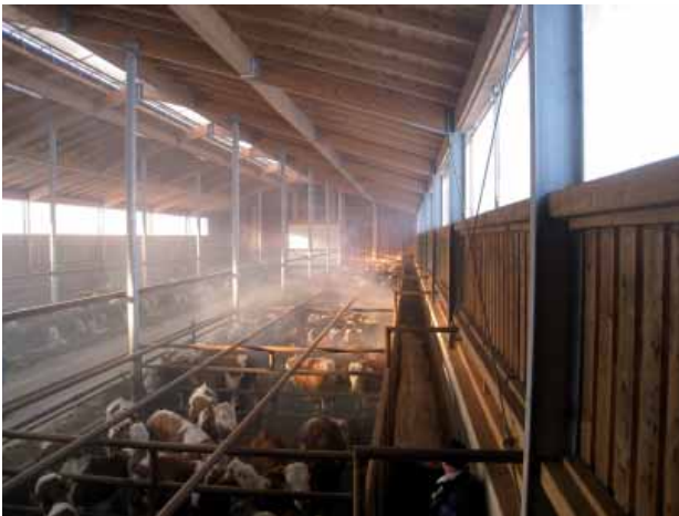
Abbildung 4: Zuluft kommt durch den Spaltenboden in den Liegebereich hoch
