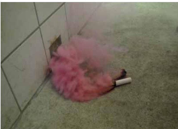
Abbildung 5: Einsaugen von Falschluff über den Güllebereich
