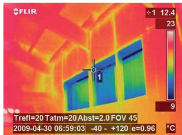
Abbildung 1: Thermografische Aufnahme der Zuluftöffnung
