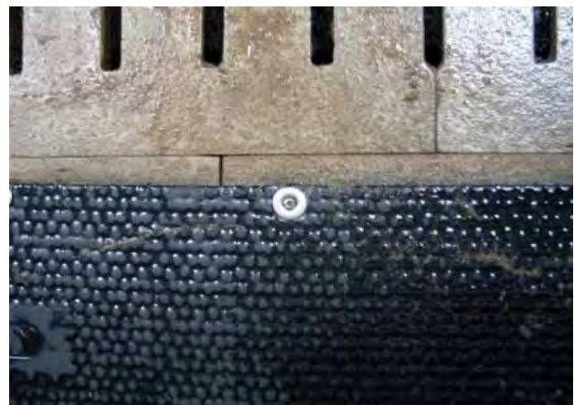
Abbildung 1 und 2: Matte mit Pyramidenprägung und L-Profil-Edelstahlschiene als Kantenschutz
