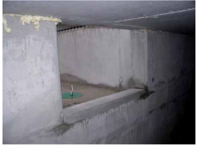
Abbildung 4: Zuluffführung in das Abteil
