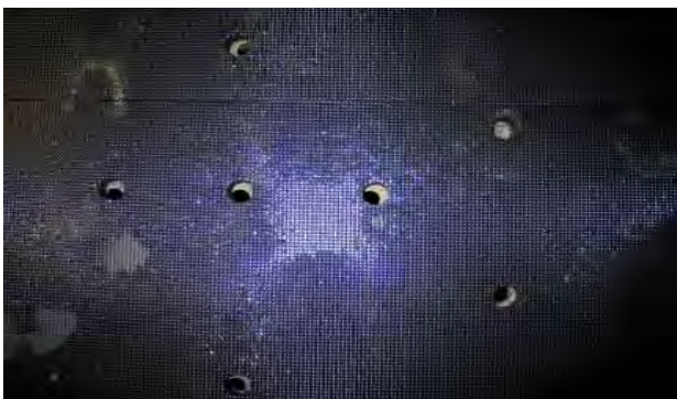
Abbildung 8: Löcher werden nachträglich mit einem Lochschneider geschnitten
