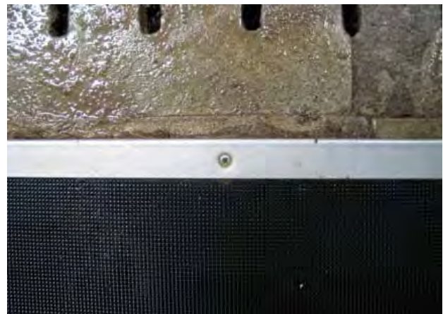
Abbildung 1 und 2: Matte mit Pyramidenprägung und L-Profil-Edelstahlschiene als Kantenschutz
