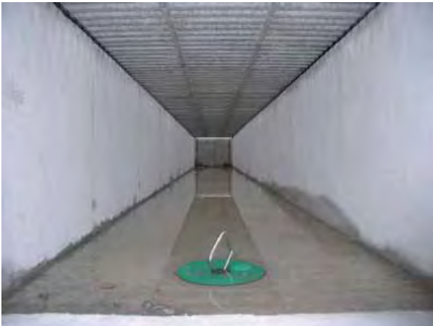
Abbildung 5: Das Wasser im Kanal kühlt die Luft durch die freiwerdende Verdunstungsenergie und erhöht die Luftfeuchtigkeit Wasserstand 5 cm.
