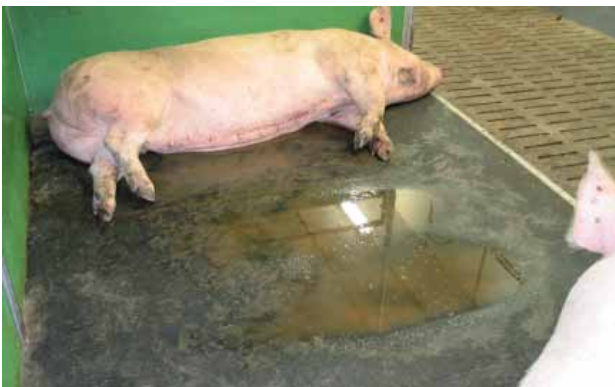
Abbildung 7: Mit der Zeit bilden sich Mulden in denen abgesetzter Harn stehen bleibt.
