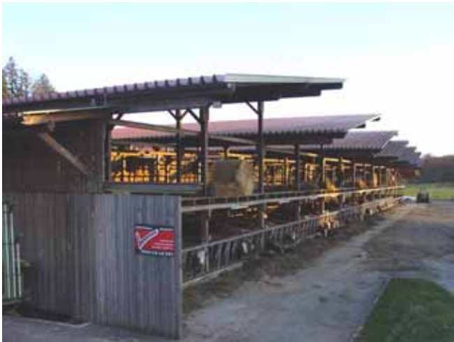
Bild 6: mehrhäusiges Stallgebäude mit Pultdächern
