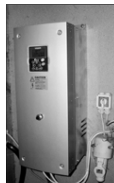
Abbildung 9: Frequenzumformer
