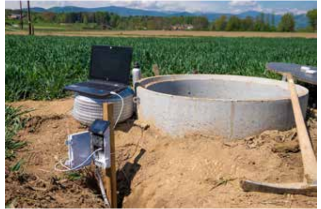
Abbildung 4: Einbau Bodenfeuchtesensoren, © LK Steiermark.
