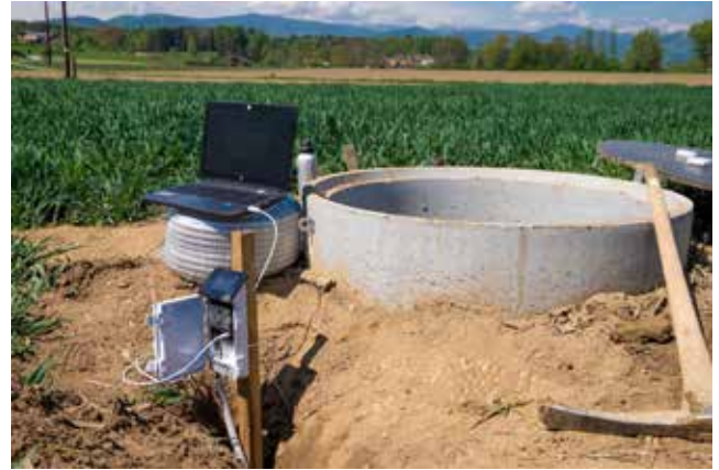
Abbildung 4: Einbau Bodenfeuchtesensoren, © LK Steiermark.
