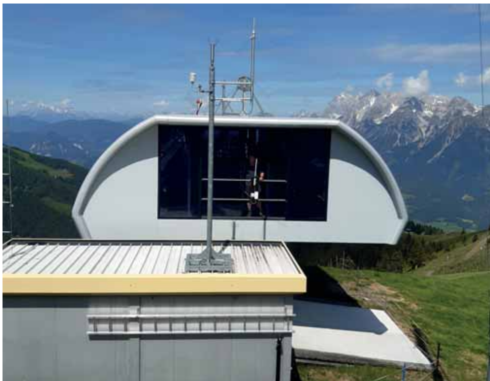
Abbildung 2: LORA Antenne Hauser Kaibling, Bergstation Gipfelloift
