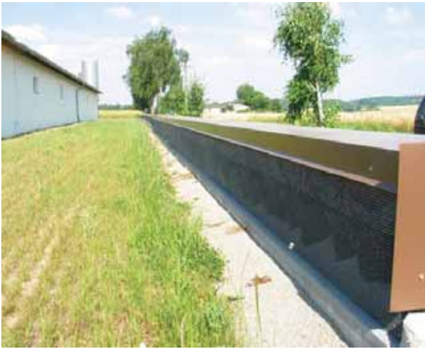
Bild 4: Erdwärmetauscher (Quelle: LSZ Boxberg)
