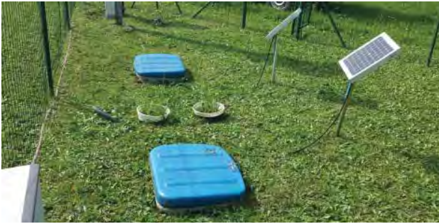
Abbildung 2: NITRATMO-Messsysteme installiert am Standort Wagna (Aufnahme vom 18.9.2014).
