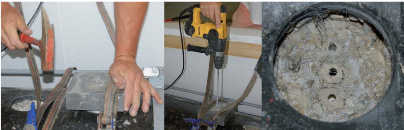
Abbildung 3: Herstellung der Bohrungen in den Schotter
