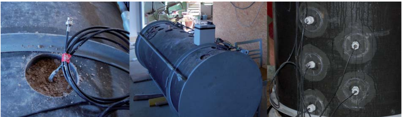
Abbildung 6: Abschluss der TDR-Sonden Installation
