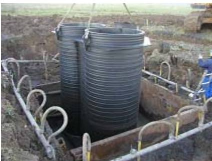
Abbildung 2: Einbau der Containerstation in den Kippenstandort
