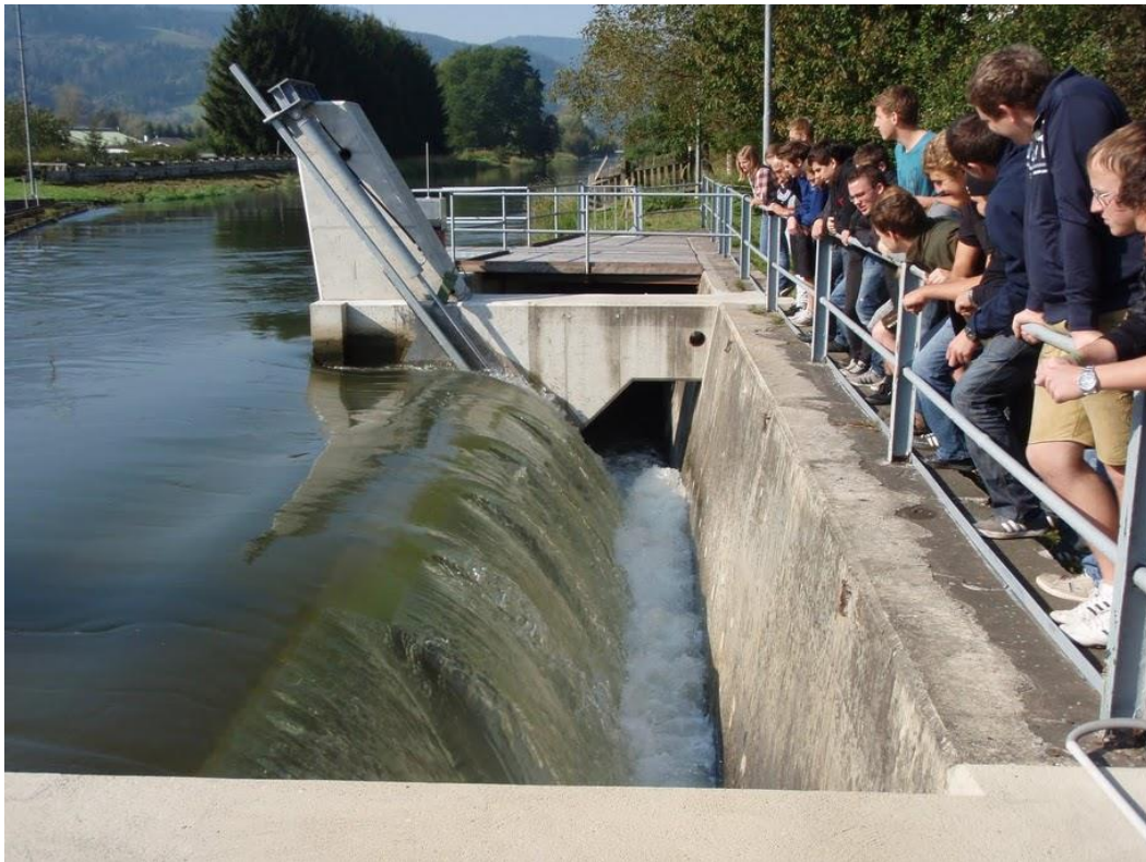
Abbildung 8: Exkursion „Wind, Wasser – Live“ – Schaukraftwerk Bruck/Mur
