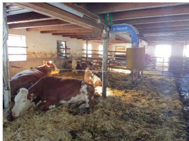
Abbildung 6: Dieses Altgebäude wurde zu einem Tretmiststall umgebaut. Die bestehende Schubstangenentmistung wird weiterhin genutzt. Foto: Promegger
