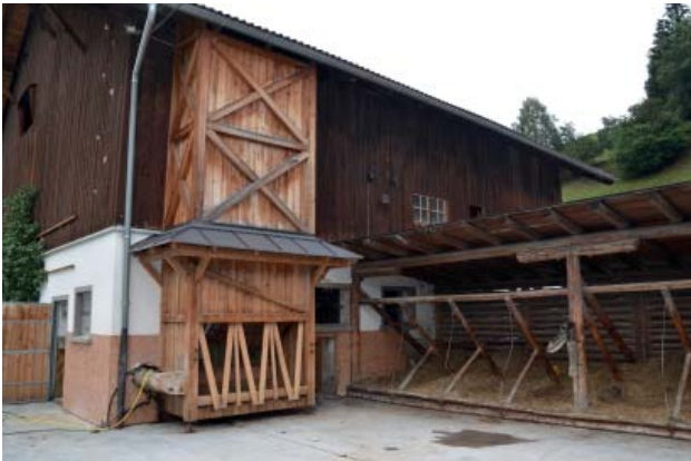
Abbildung 3: Eine Heuraufe, welche direkt vom Heulager aus bestückt werden kann. Foto: Promegger
