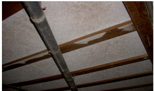
Abbildung 2: Klassische Porendecke (Holzwolleplatte mit Dämmstoffauflage)
