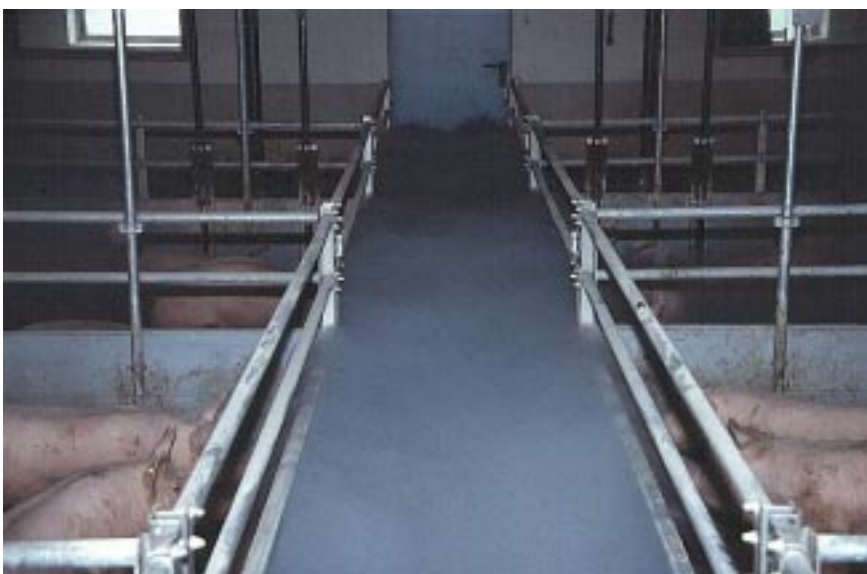
Abbildung 3: Buchtentrennwand zum Betriebsgang zu niedrig
