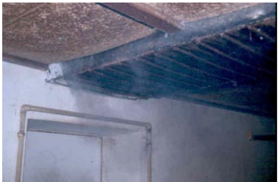
Abbildung 2: Undichte Lüftungsdecke
