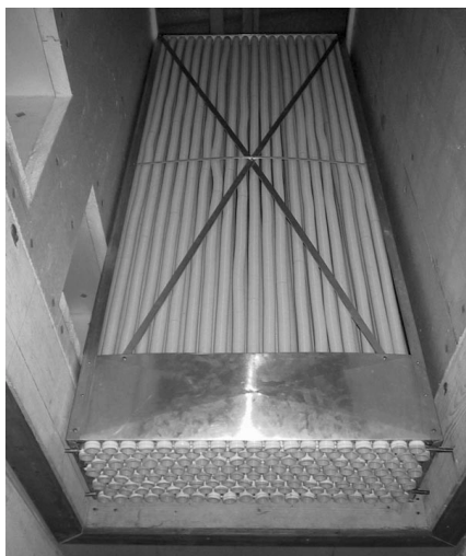
Abbildung 16: Grundgerüst aus Nirosta mit Installationsrohren
