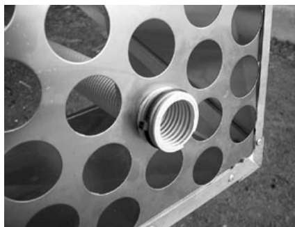
Abbildung 17: Anbringung der Rohre
