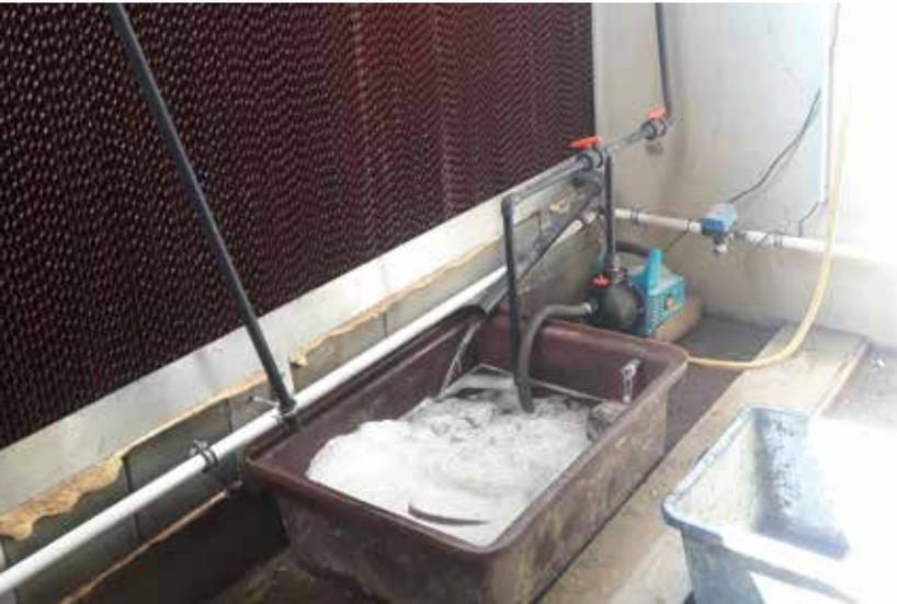
Bei Coolpads werden Zellulosewaben mit Wasser berieselt
