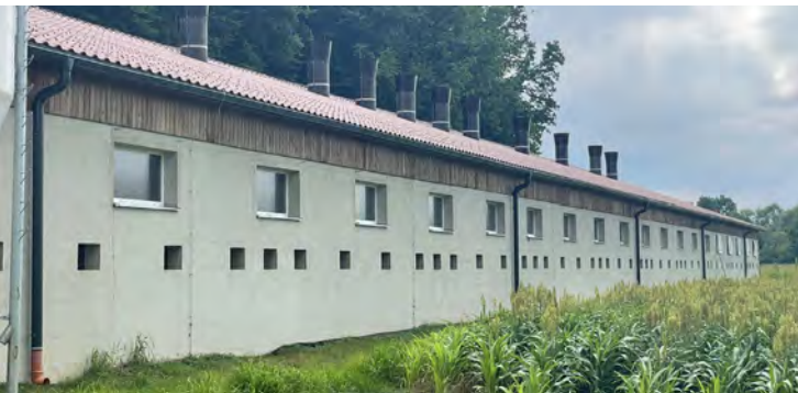
Dacheindeckungen erhitzen sich unterschiedlich
