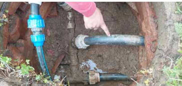
Bei den Verteilerschächten werden die oberirdischen Verteilereinheiten (7 Regnerlanzen mit Schläuchen in Serie verbunden) angeschlossen Foto: A. Pöllinger-Zierler
