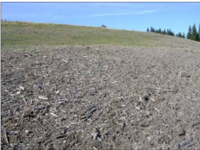
Bild 33 und 34: Oberfläche nach der Bearbeitung mit einer Stockfräse, das oberflächliche Holzmaterial ist sichtbar
