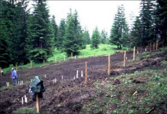
Bild 1: Zustand der Versuchsfläche vor bzw. während der Anlage der unterschiedlichen Varianten im Juli 1998 am Standort Scharberg, im Hintergrund ist noch der Wald erkennbar, der kurz darauf abgestockt wurde
