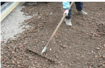
Abbildung 19: Einbau der Baustoffrecyclingvegetationstragschicht
