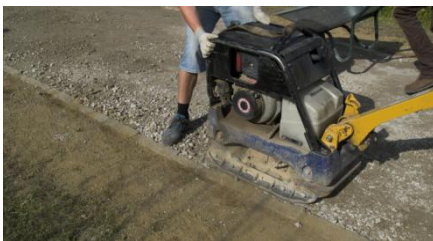
Abbildung 17: Vorbereitung des Planums der Kalkvegetationstragschicht
