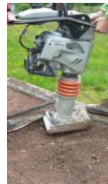
Abbildung 14: Verdichteter 0/45 Baustoffrecyclingvegetationstragschicht
