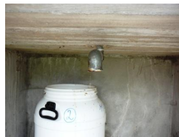
Abbildung 10: Behälter zur Sickerwassermessung in Gumpenstein
