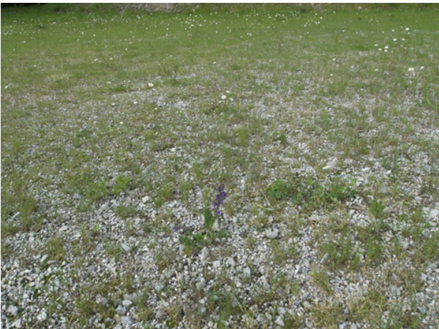
Abbildung 10: Schotterrasen, begrünt mit Wildpflanzensaatgut (Parkplatz Gosaubahn, 1.200m)
