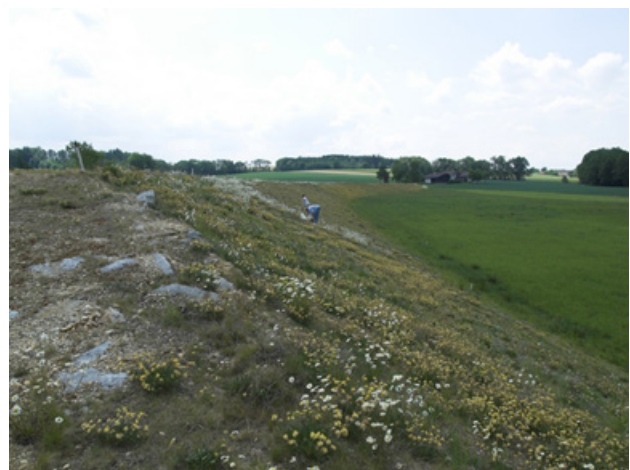
Abbildungen 6-8: Standortgerechte Dammbegrünung mit Wildpflanzensaatgut (Stillbach, OÖ)
