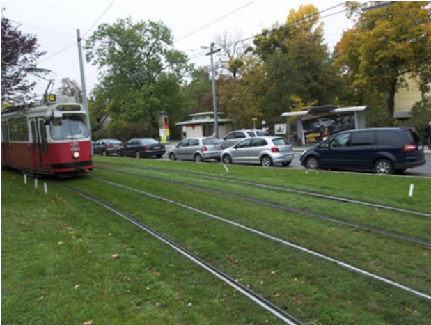
Abbildung 9: Gleisbegrünung mit Wildpflanzensaatgut in Wien
