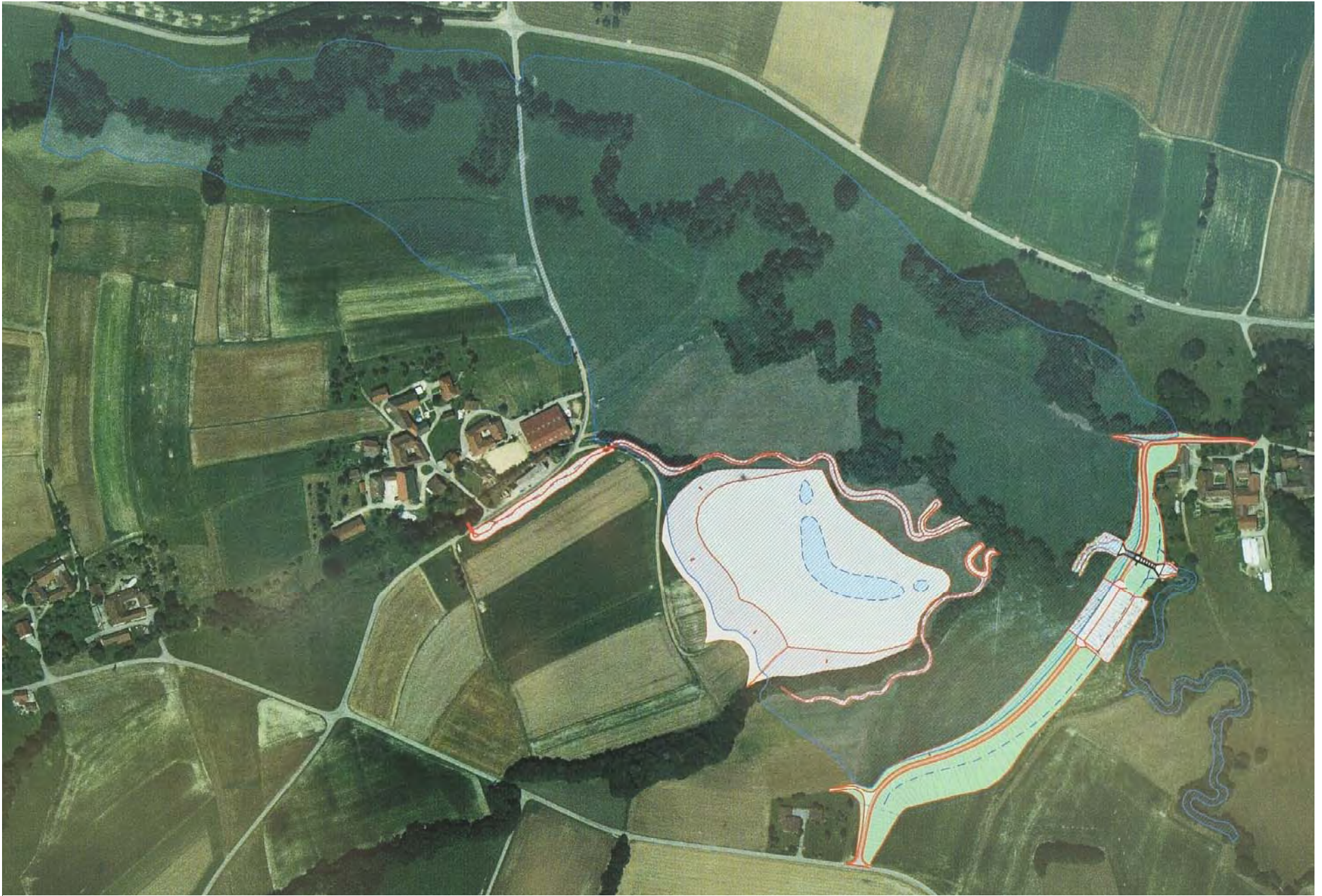
Hochwasser-Rückhaltebecken Stillbach, Oberösterreich
