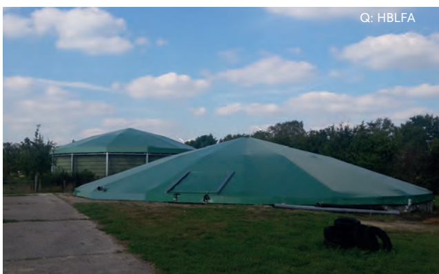
Abbildung 39: Güllelagerabdeckungen helfen gasförmige N-Verluste in Form von Ammoniakemissionen zu verhindern.
