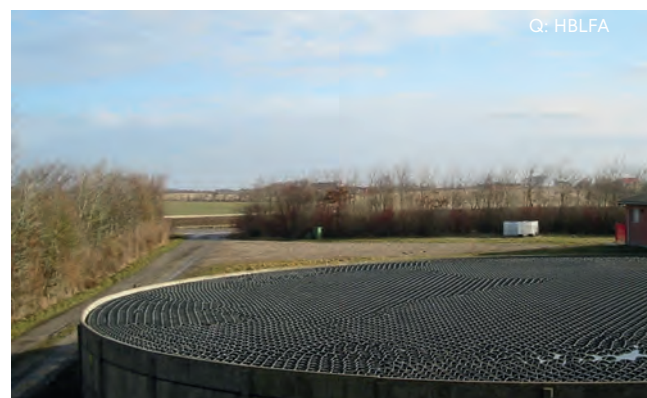
Abbildung 40: Schwimmkörper können bei Gülle ohne Schwimmdeckenbildung als Güllelagerabdeckung verwendet werden.
