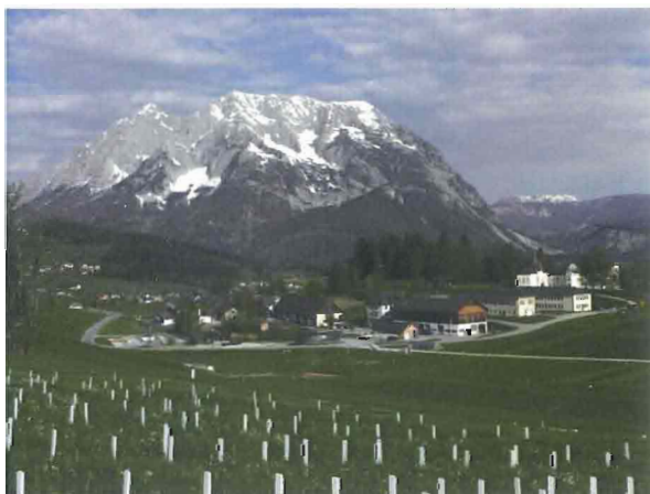
Gesamtansicht Lehr- und Forschungszentrum Raumberg-Gumpenstein
