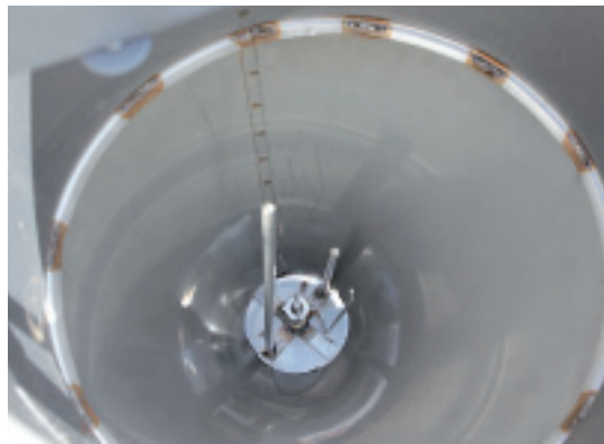
Innenansicht des Behälters.
