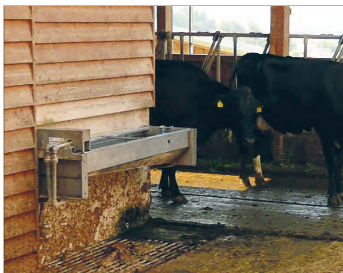
Ein Gitterrost mit Abfluss verhindert im Außenklimastall das Vereisen des Tränkeumfelds im Winter.
