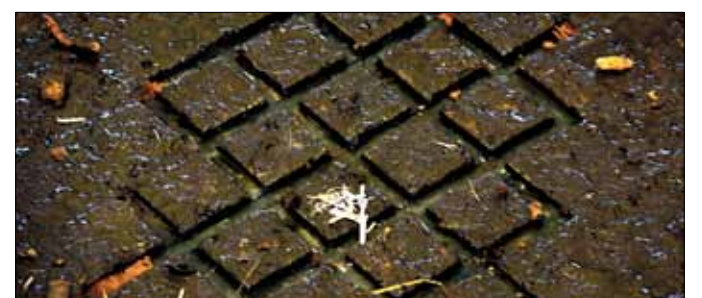
Rund zehn Millimeter tief ist das endgültige Profil. Das ist tief genug, damit Flüssigkeit ablaufen kann und die Oberfläche trocknet.
