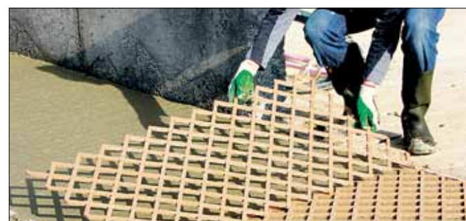
Die Holzrauten werden in den noch frischen Beton eingelegt.
