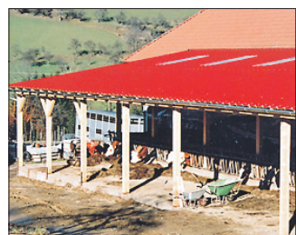
Spezielle Dacheindeckung FOTO: EISEN HOFER
