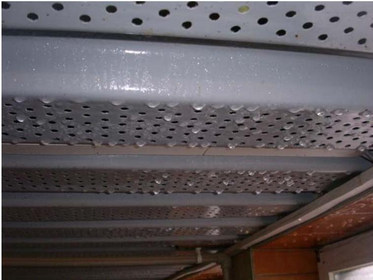
Kondensattropfen aufgrund zu großer Temperaturunterschiede (Zulufttemperatur zu niedrig)
