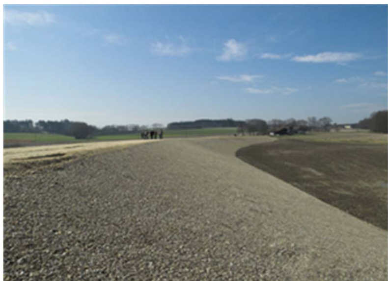
Abb 7: Der Hochwasserdamm für das Rückhaltebecken Stillbach unmittelbar vor der Begrünung
