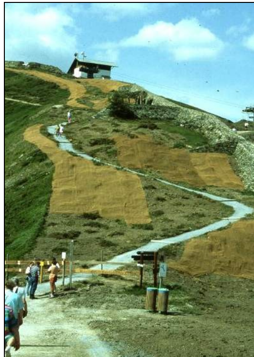
Abbildung 5: Die Verwendung der Saat-Soden-Methode unmittelbar nach der Fertigstellung. Foto: H. Wittmann
