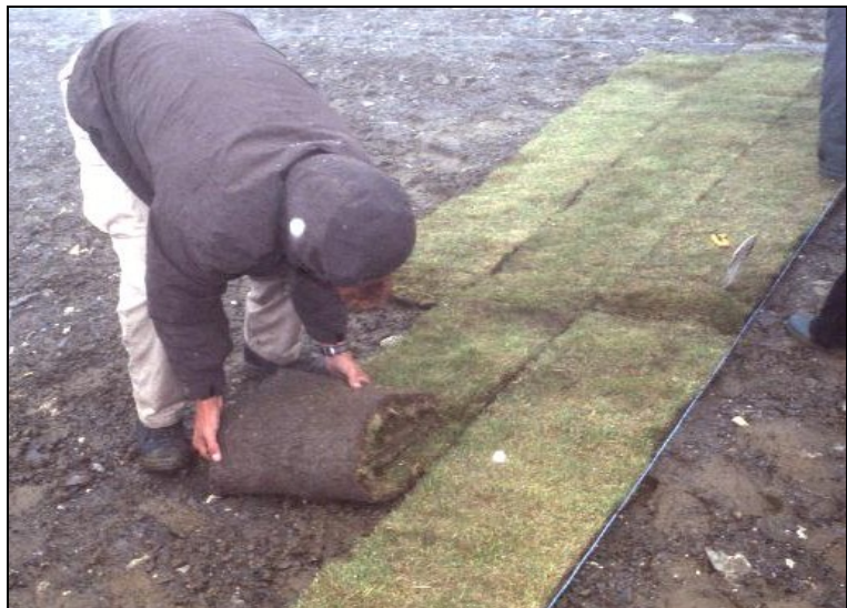
Abbildung 3: Verlegung alpiner Rollrasen in einem ersten Praxisversuch
