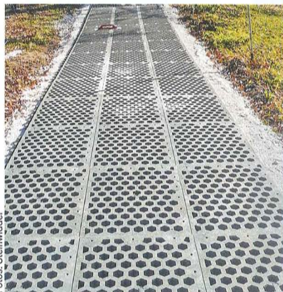
Kunststoffgitter werden nach dem Verlegen mit Sand aufgefüllt.
