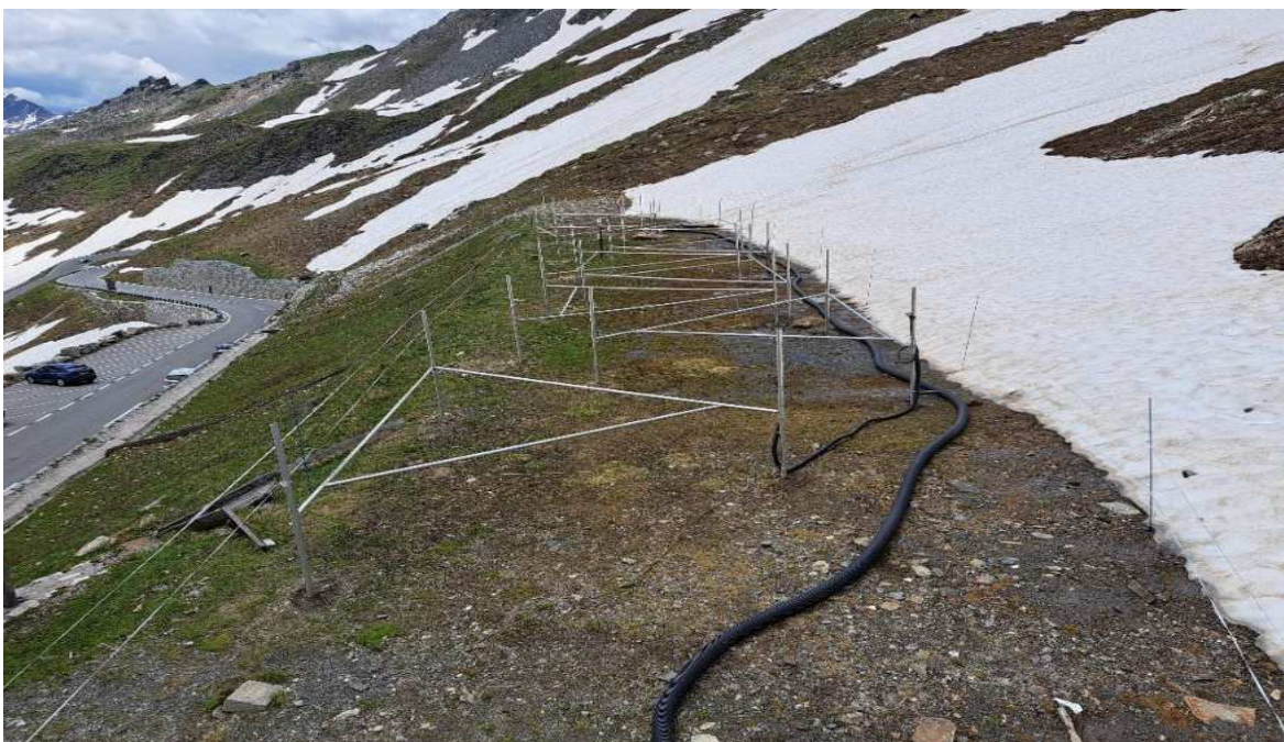
Abbildung 6 Trägergerüste für das Infrarot-Heizungssystem inkl. Verkabelung
