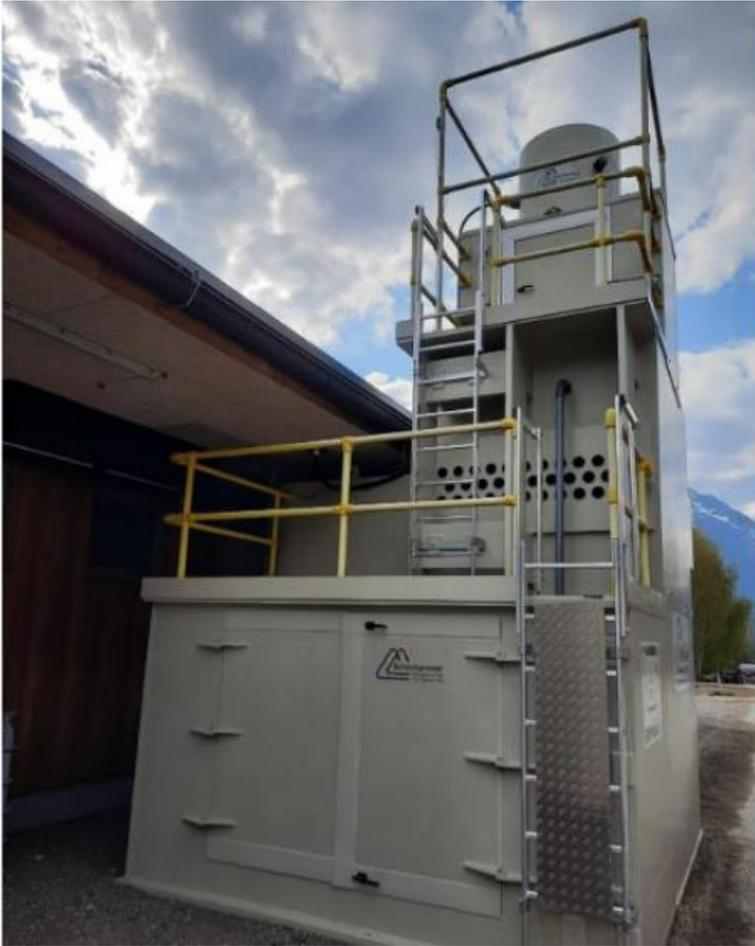
Abbildung 2 Umgebaute Tauschwäscheranlage der Firma Schönhammer am Standort Gumpenstein
