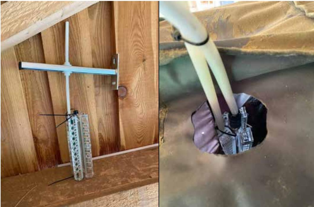
*Abbildungen 6 und 7: Einbau des Ionisators in den vet.smart.tube (Quelle: Neumayer, 2022)*
