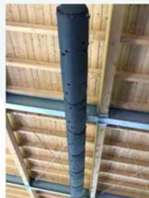
Abb.2: Eine Schlauchbelüftung am Testbetrieb Brandstätter
