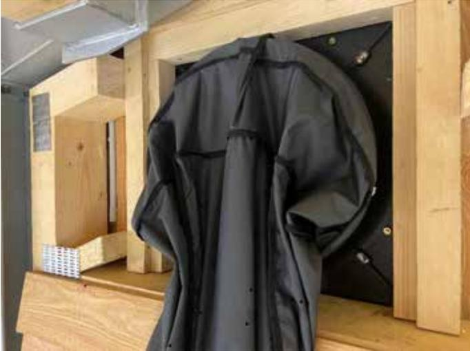
Abbildung 3: Einbau der Schlauch-/Ventilationseinheit in die Gebäude-Außenhülle (Quelle: Neumayer, 2022)
