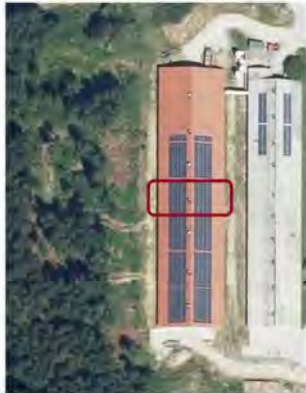
Abbildung 9: M1 mit Markierung des Probenahmekamins; Quelle: GIS
