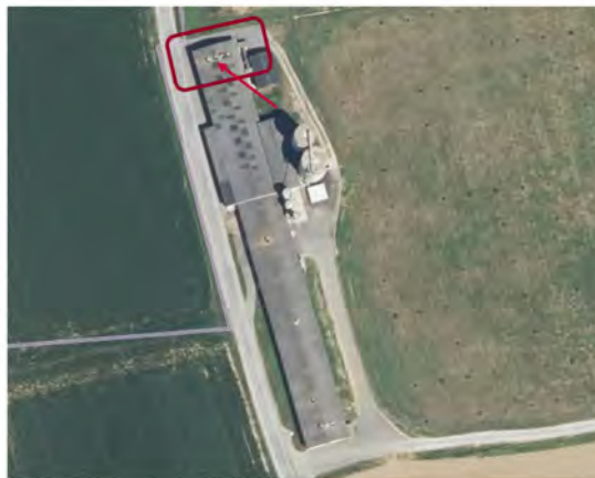
Abbildung 6: L1 mit Markierung der Abluftkamine; Quelle GIS Steiermark
