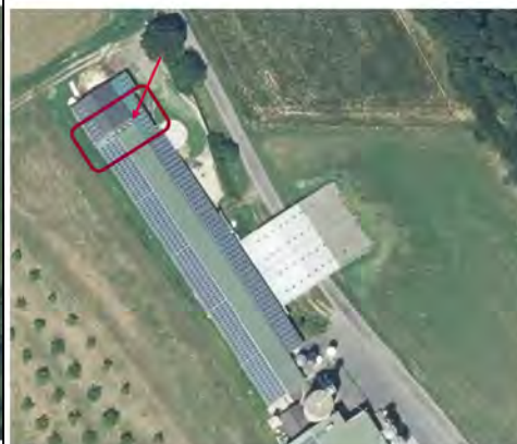
Abbildung 8: L3 mit Markierung der Abluftkamine; Quelle GIS Steiermark
