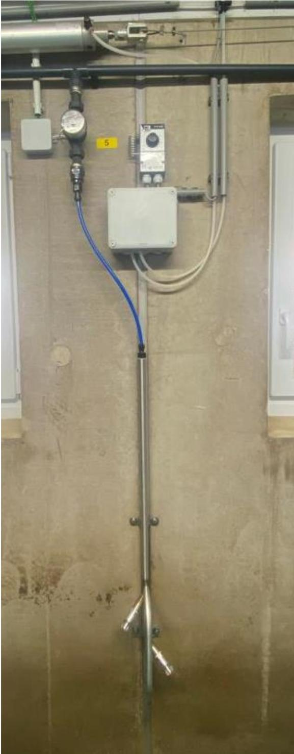
Abbildung 10: Tränkenippel-Kombination und Anschluss an Wasserzähler (Quelle: Auth, 2023)
