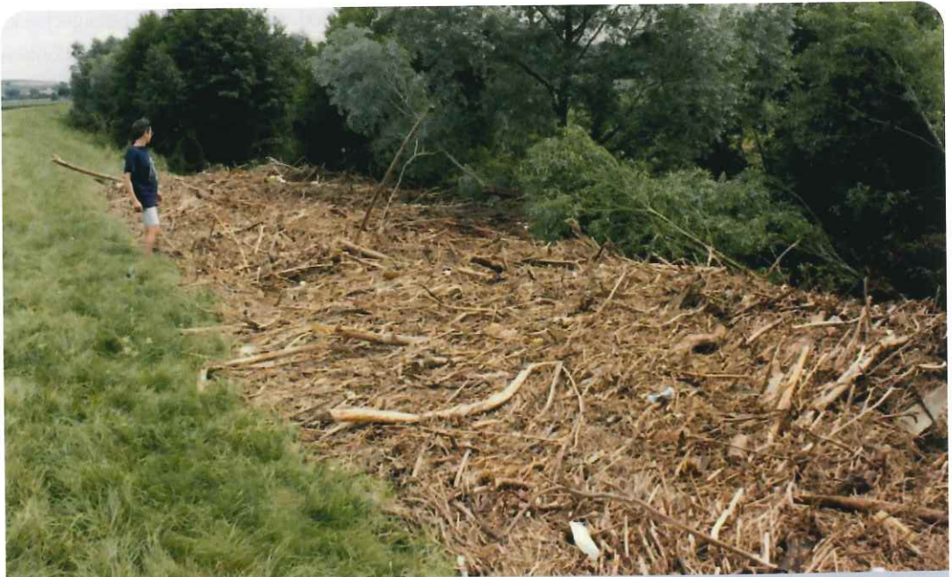
Abbildung 6: Verkläuerungsstelle an der Perschling, Foto: Gemeinde Perschling (1997).
