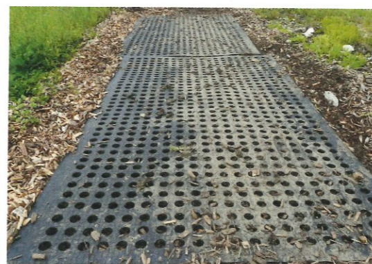
Kurze Strecken können auch mit Lochmatten befestigt werden, die jedoch entsprechend teuer sind.
