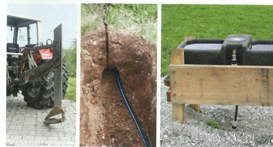
Mit einem Maulwurfpflug können Sie sehr rasch Wasserleitungen verlegen.
