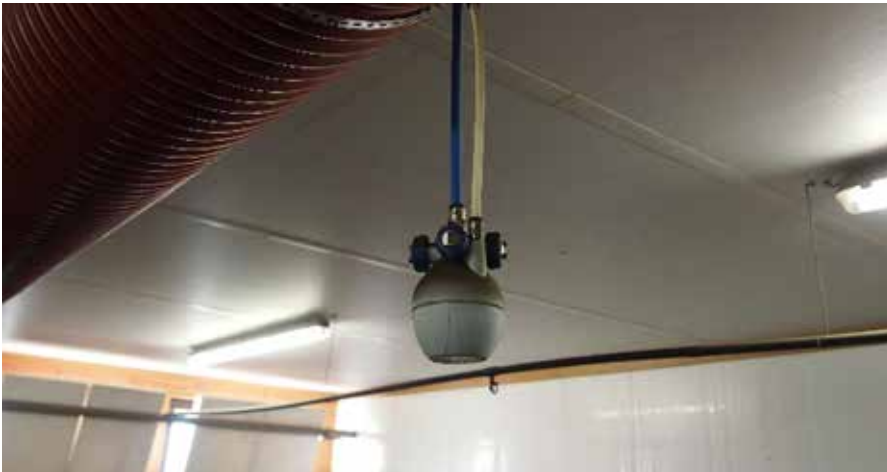
Abb. 4b: Sprühkopf eines Zweistoffdüsensystems.
