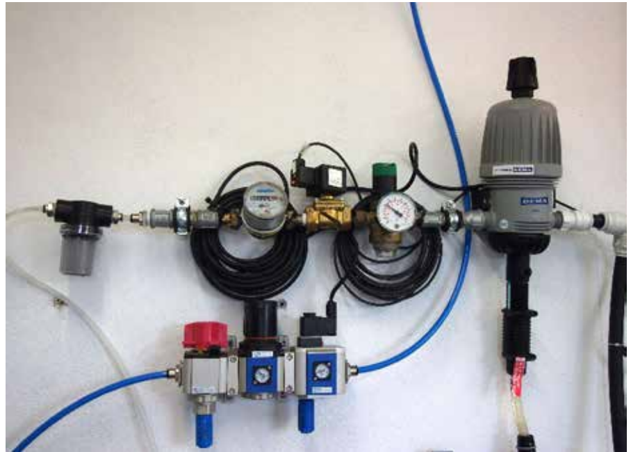
Abb. 4a: Technischeinheit des Zweistoffdüsentystems (HBLFA, 2020)
