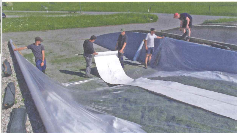
Landwirten/innen stehen verschiedene Abdeckmöglichkeiten für Flachsilos zur Verfügung. Die Qualität des Systems und dessen sachgerechte Installation sind entscheidend für den Gärerfolg. Foto: Resch
