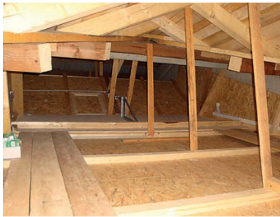
Anlagen, die warme Luft unter dem Stalldach absaugen, sind kostengünstig in Anschaffung und Betrieb. Foto: Pöllinger
