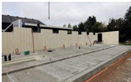
Der Kran richtet es: Fertigbauteile fügen sich aneinander.
