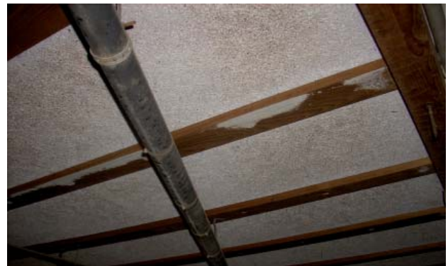
Abbildung 2: Klassische Porendecke (Holzwolleplatte mit Dämmstoffauflage)
