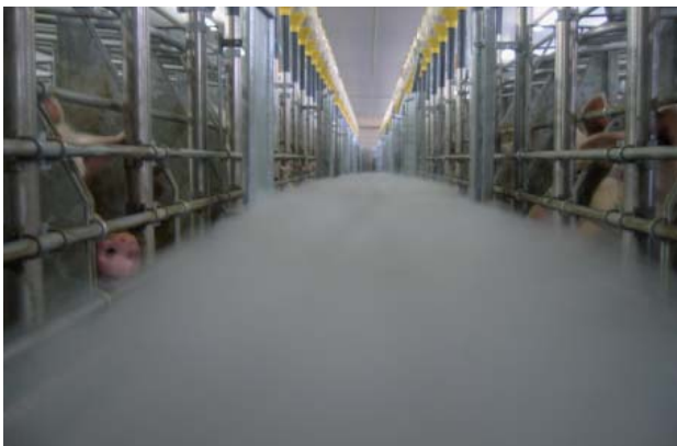
Abbildung 4: Strömungsbild der Unterflur-Zuluftanlage (Frischlufte im Kopfbereich der Sauen)
