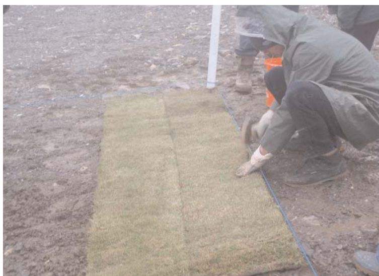
Abbildung 7: Verlegung alpiner Rollrasen in einem ersten Praxisversuch
