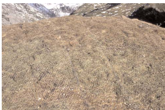
Abbildung 5: Eine Heumulchsaat, die wegen Windexposition mit einem Drahtgitter abgedeckt wurde
