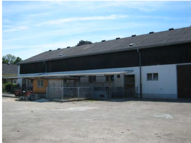
Abbildung 35: Stallgebäude von außen
