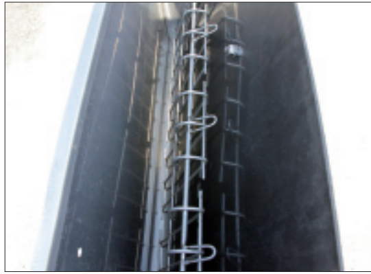
Innenansicht vom Vorratsbehälter.
