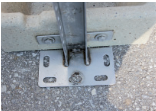
Die Befestigungsplatte ist etwas klein ausgefallen.
