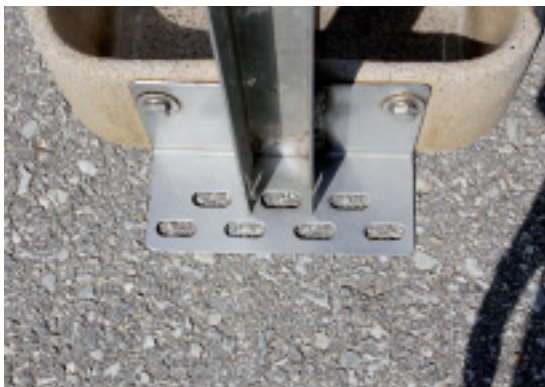
Die Befestigungsplatte ist etwas klein ausgefallen.
