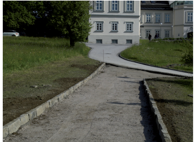
Abbildung 12: verdichteter Unterbau mit verlegten Randsteinen
