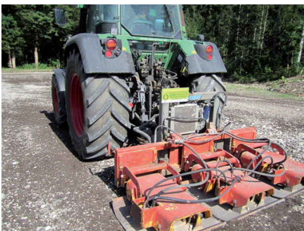
Abbildung 7: Verdichten der Vegetationstragschicht nach der Einsaat, Schotterrasen Zwieselalm (Gosau, August 2011, Foto Urstöger)
