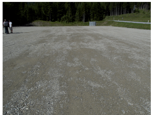
Abbildung 3: eingeebnete Schotterfläche, Schotterrassen Zwieselalm (Gosau, August 2011)
