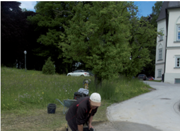
Abbildung 16: Einsaat der verdichteten und befeuchteten Vegetationstragschicht (Mai 2013)
