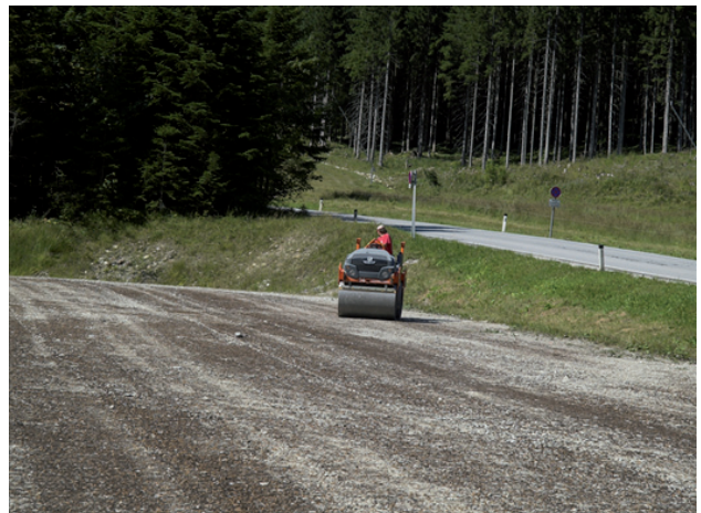
Abbildung 9: nochmaliges Walzen der eingesäten Fläche nach Überprüfung der Tragfähigkeit, Schotterrasen Zwieselalm (Gosau, August 2011)
