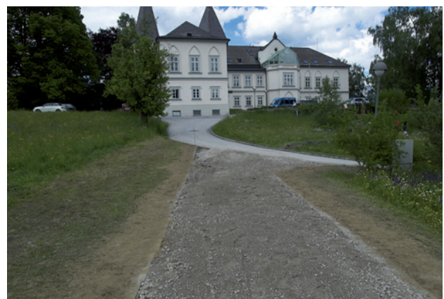
Abbildung 14: eingebaute Vegetationstragschicht vor dem Verdichten (Mai 2013)
