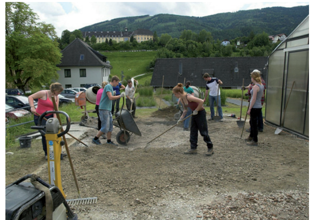
Abbildung 13: Einbau der Vegetationstragschicht durch Studenten der Universität für Bodenkultur (Mai 2013, Foto Aeberli)
