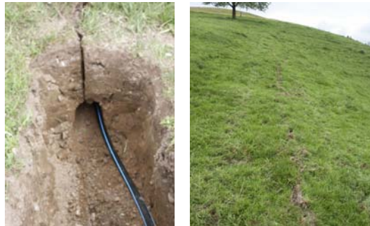
Abb. 5 u. 6: Verlegung der Wasserleitung mit dem Maulwurfspflug
